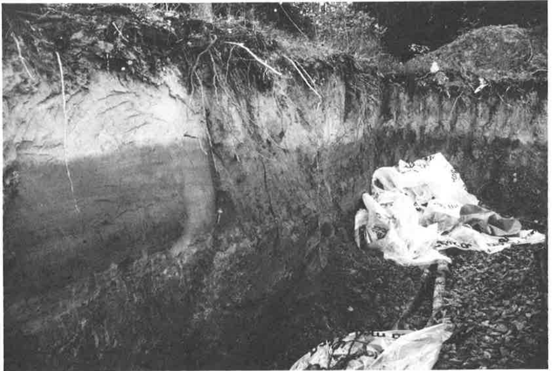
Fig. 13. Snitt fra byggetomt ved Grinder (324 783).
