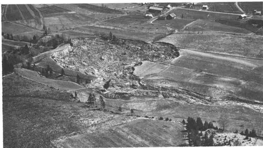
Fig. 22. Leirskredet ved Borgen (224 643). Sett mot sørøst. Foto: Fjellanger/Widerøe mai 1954. The quick-clay slide at Borgen (224 643). Photo towards southeast.
