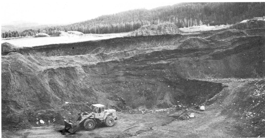
Fig. 10. Breelvavsetningen ved Frigården (956322). Foto tatt mot øst.
