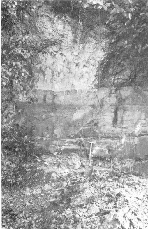
Fig. 13. Elveavsetninger dekket av skredmateriale ved Flå. Fluvial sediments covered by slide deposits at Flå.
