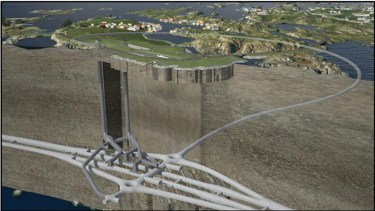
Figur 2.7: ROGFAST-tunnelen skal bygges med to løp og med to felt i hver retning. Avstikker til Kvitsøy krever et planfritt kryss i dypet. I tillegg er det nødvendig med omfattende ventilasjon (mørkere grå farge). (Illustrasjon: Statens vegvesen).
