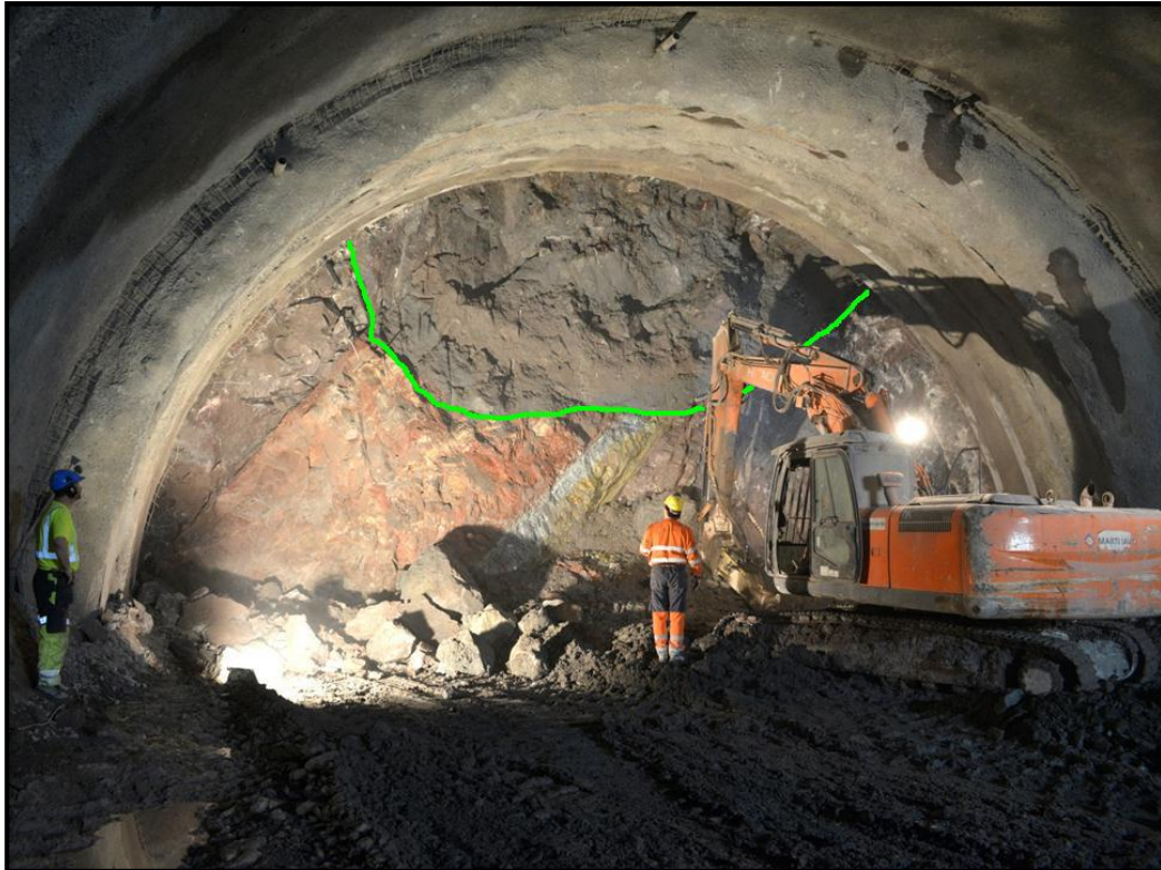
Figur 3.34: Løsmasser (over den grønne streken) på tunnelstuppen ved driving av Holmestrandporten. (Foto: Jernbaneverket / BaneNor).
