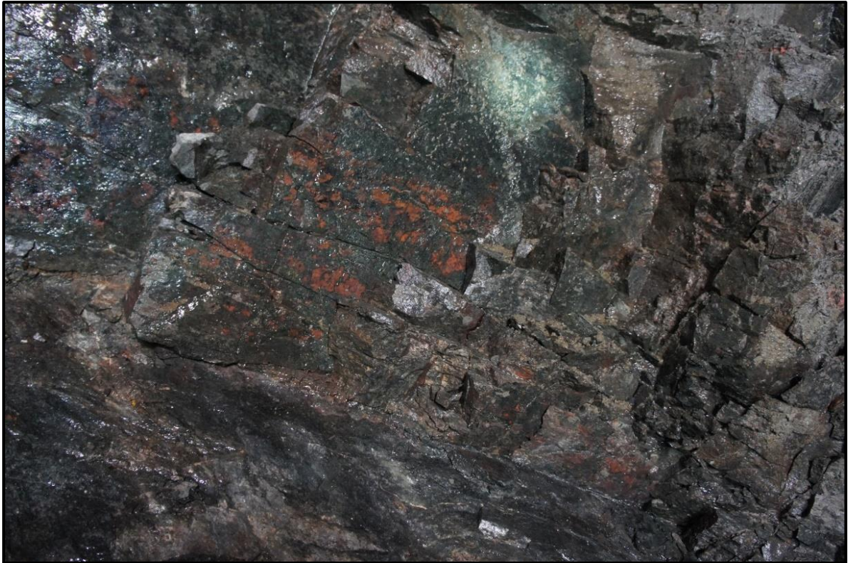
Figur 5.10: Bilde fra stoffen ved PEL 4717. Rødfarge (Hematitt) opptrer på begrensede flater som sprekkebelegg i til dels dårlig berg (Foto: Svv).
