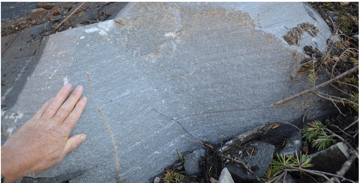
Figur 14: Nærbilde fra nordlige del av skjæringen i Figur 13, som viser skifer med 1-3 cm spaltetykkelse.
