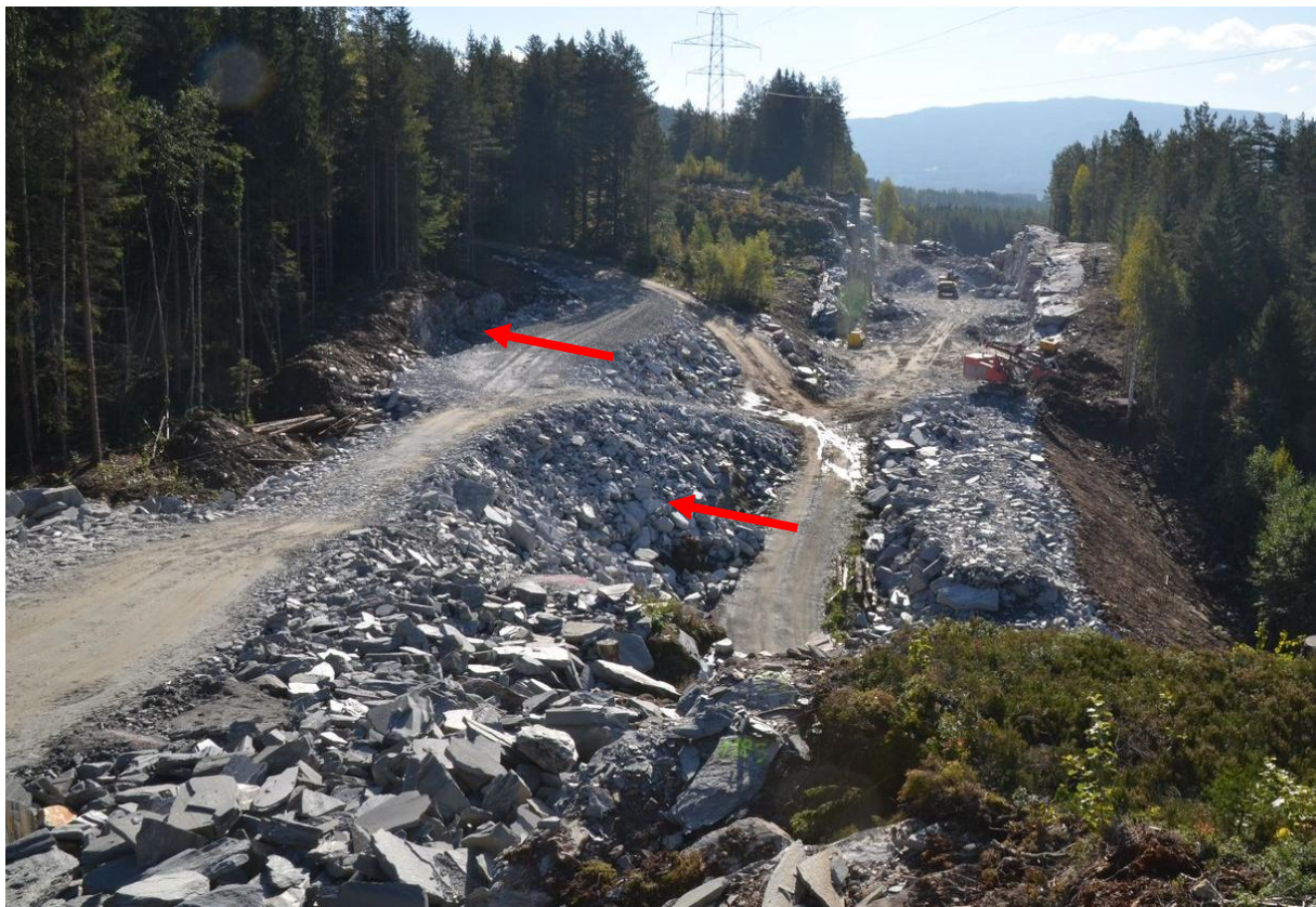
Figur 2: Deler av den nye delvis utsprengte veitraséen for fylkesvei 40 sett mot sør fra koordinat 1050 m i profilet (se vedlegg). Den nåværende veien opp til Helgesplass sees midt på bildet. Pilene viser hvor det gamle skiferbruddet var, samt skjæringen vist i Figur 9.
