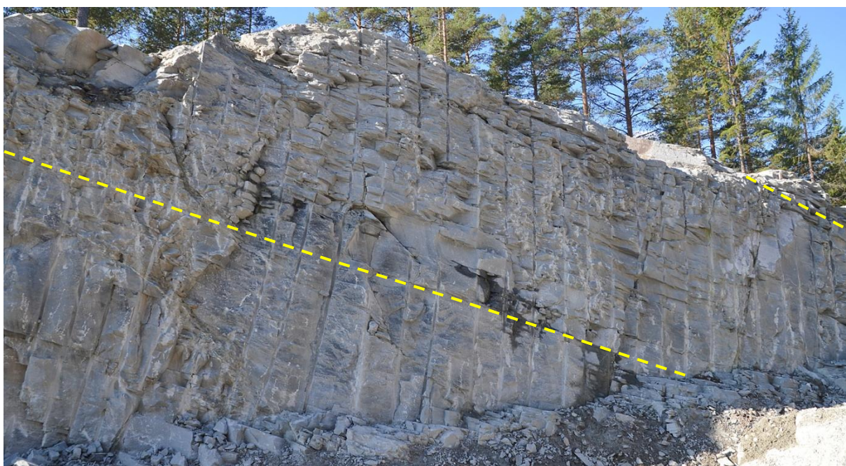
Figur 12: Sørlige avgrensning av øvre sone (over øverste stiplet linje) ved koordinat 925 m i veiprofilet. Mellom linjene er bergarten mer grovspaltende (grønn markering i kart i vedlegg), mens under nedre linje er bergarten i stor grad uegnet (blå markering i kart). Bilde tatt mot vest.
