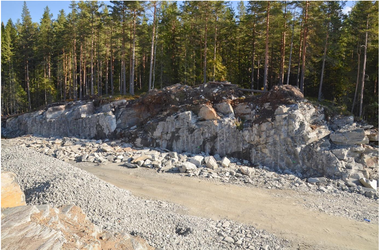
Figur 13: Veiskjæring sett mot NØ fra koordinat 1050 m. Skjæringen inneholder skifer og murestein med 1-4 cm (venstre = nordlige del) og 3-6 cm spaltetykkelse (høyre = sørlige del).
