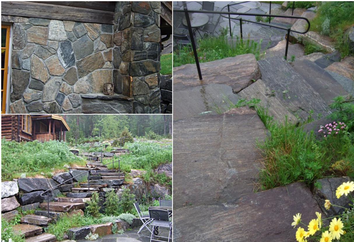
Figur 15: Bruk av murestein fra Nordre Langerud i trappeanlegg og som forblending på murvegg. Fra hytteanlegg ved Vatnås. Trappetrinnene er stort sett av øyegneiss (legg merke til stripningen i steinene som skyldes velutviklet lineasjon).
