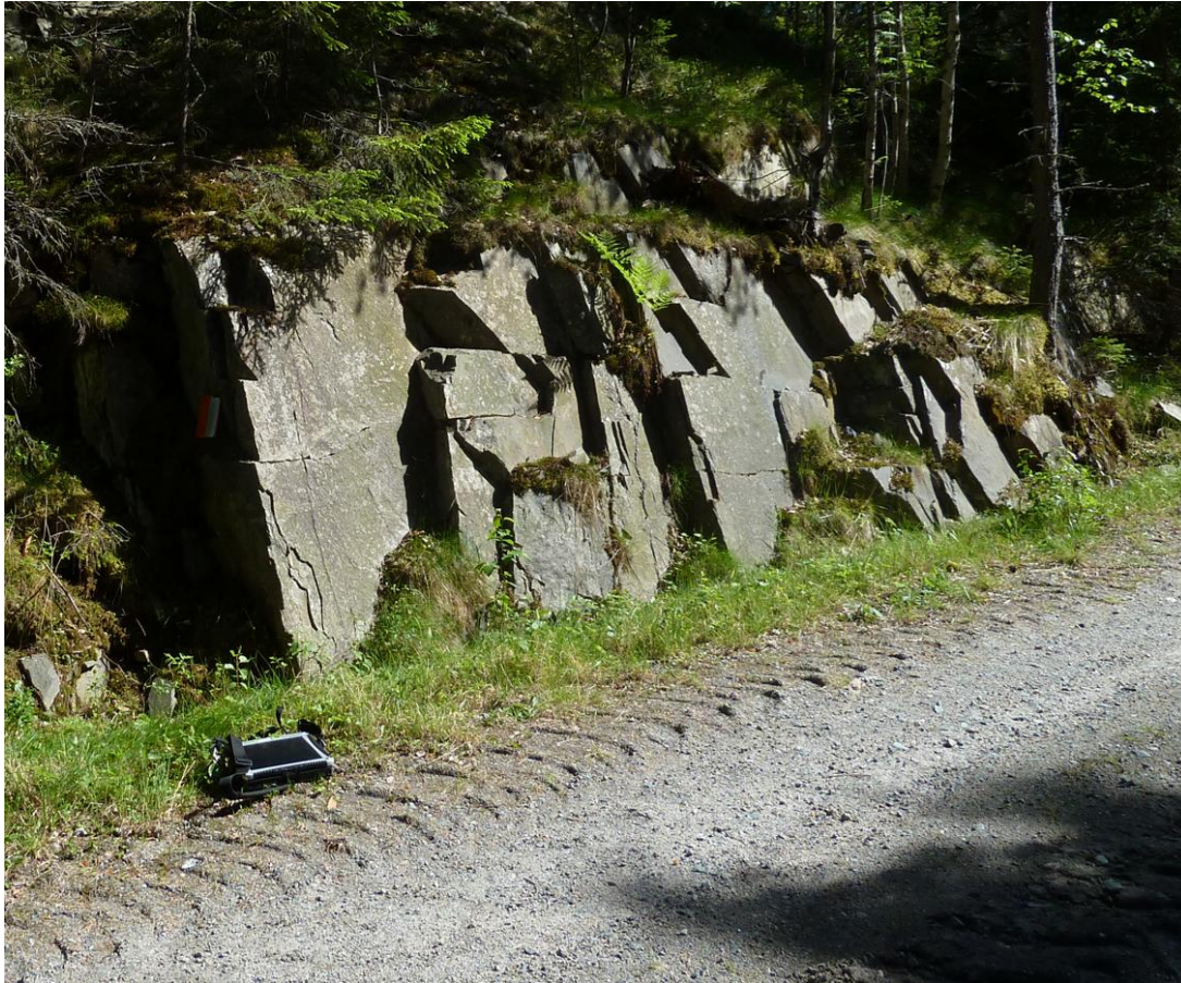
Figur 11: Lokaltet 5 sett fra nord. Det er en tydelig planskifrihet og en tverrgående oppsprekking som gir naturlige muresteinsblokker.
