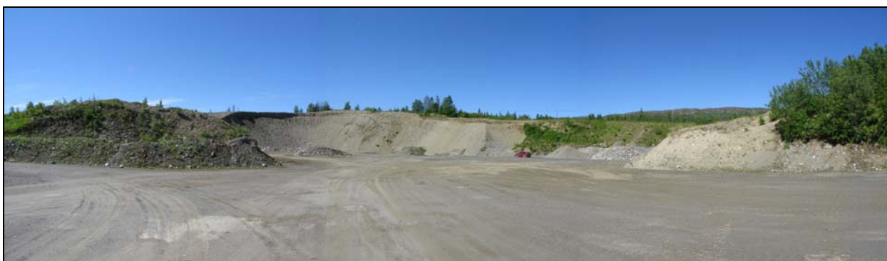
Figur 35: Tunnsjø massetak (bilde tatt mot vest).
