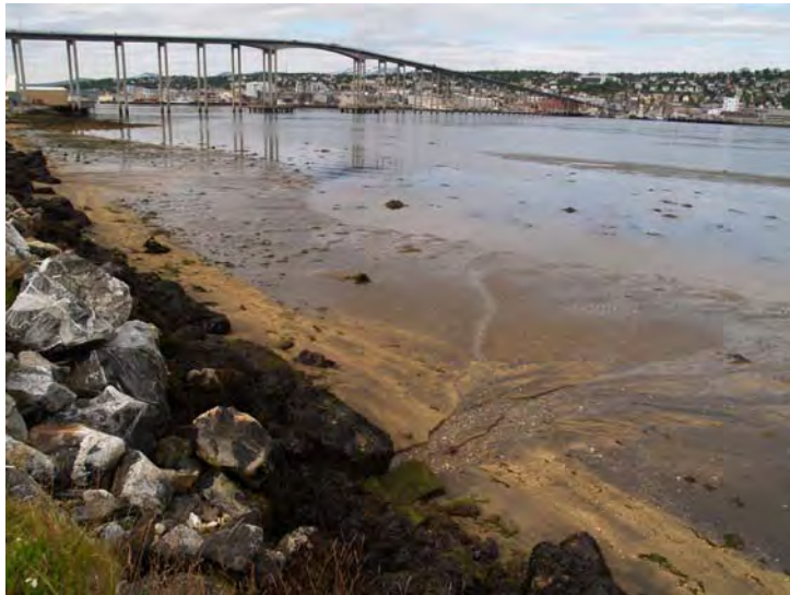
Figur 21. Utstrømmende vann fra fronten av fyllingen til Tromsøysundet på fjære sjø. Vannet eroderer seg ned i sanden (foto: Tromsø kommune, renovasjonen).
