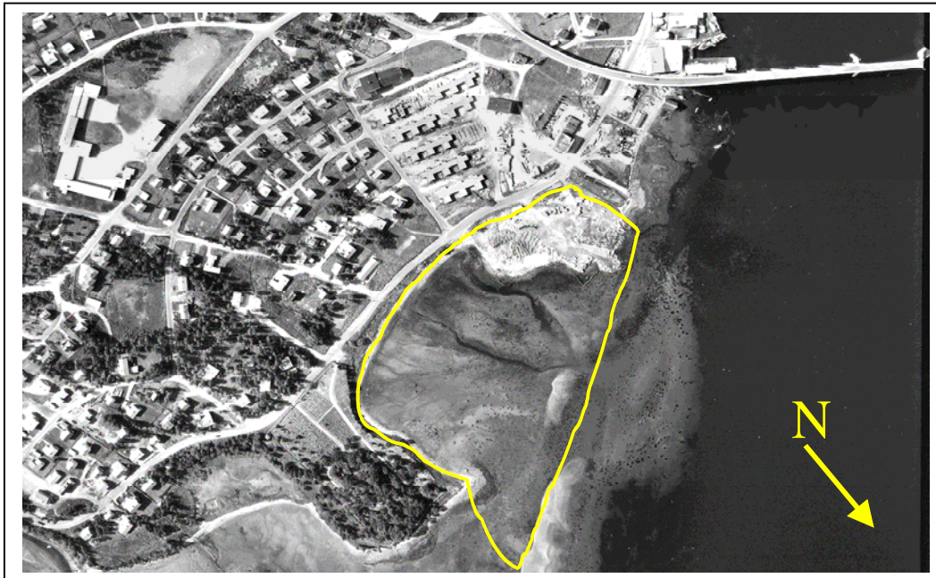
Figur 2. Luftfoto 1969 av fjæra ved Tromsøybrua med omriss av den kommunale fyllingen vest for kirkegården slik den fremstår i dag. Det er trolig påbegynt utfylling nærmest broen (foto: Tromsø kommune).
