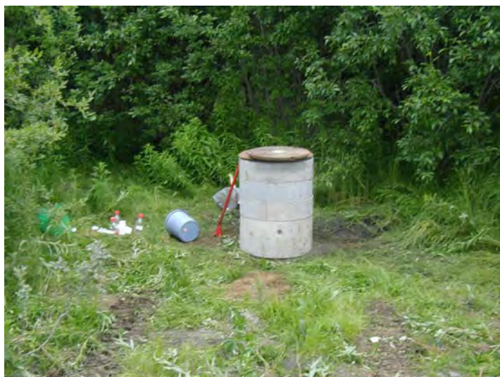
Figur 10. Brønn nr. 3 etter sikring med sementringer og kumløkk for å unngå hærværk eller annen påvirkning av peilebrønnen.
