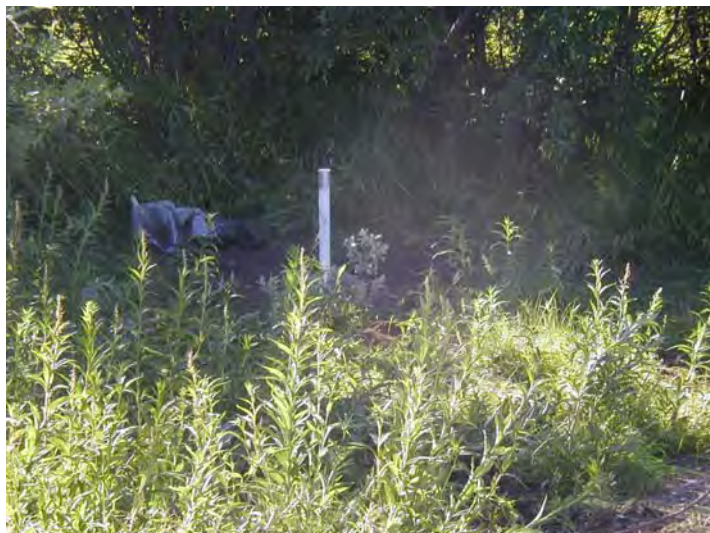
Figur 9. Brønn nr. 3, som ligger nærmest fjæra. Røret består av PEH-rør med lokk.
