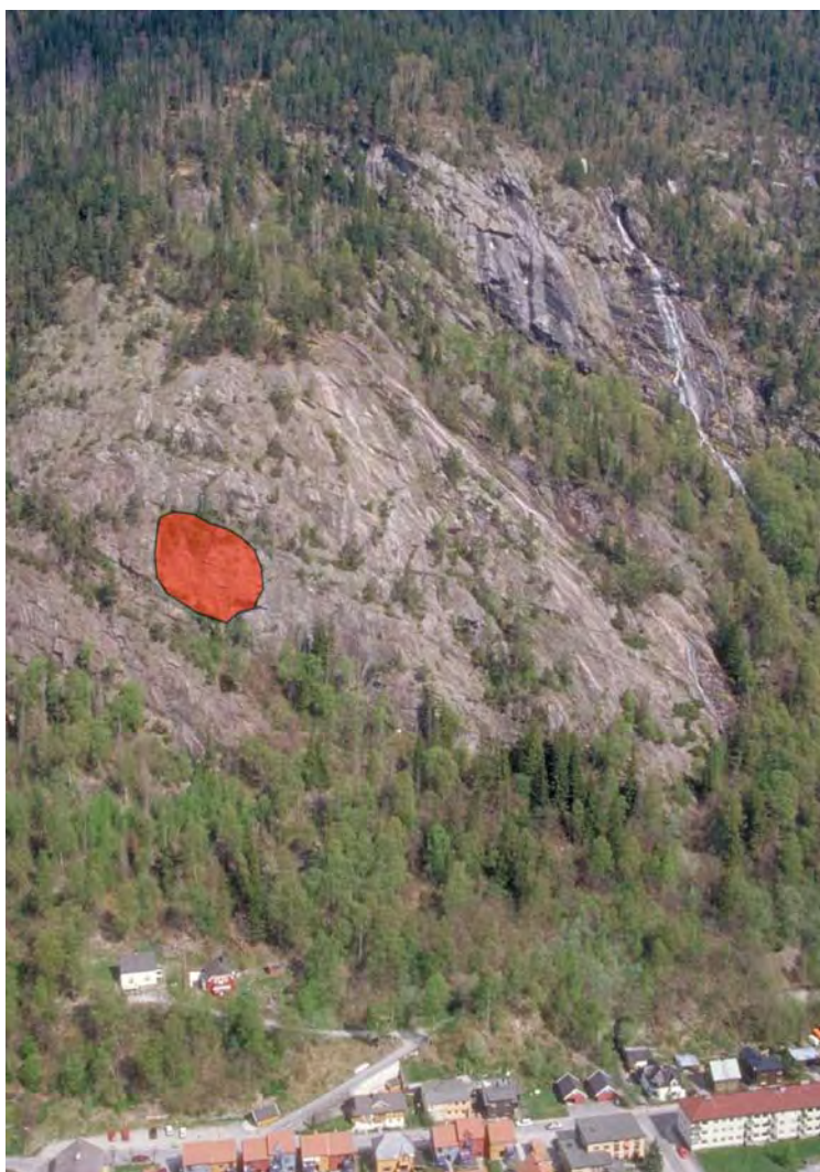
Figur 14. Skriugata vest, RN-1 i kartvedlegg 10. Markert felt har nær vertikale sprekker omtrent parallelle til fjellsiden. Feltet bør undersøkes grundigere om fare for store utfall. Foto: S.Dahlgren.
