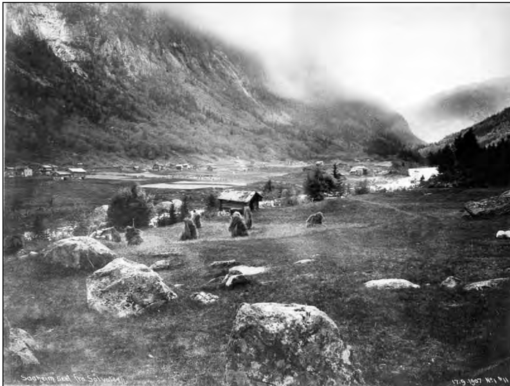
Figur 6. Foto fra før Rjukan by ble påbegynt (1907) ved Bøen som viser utløp av skredmasser helt ut mot elva forbi der hvor Sam Eydesgt ligger i dag. Arkivfoto Norsk Hydro, Rjukan.
