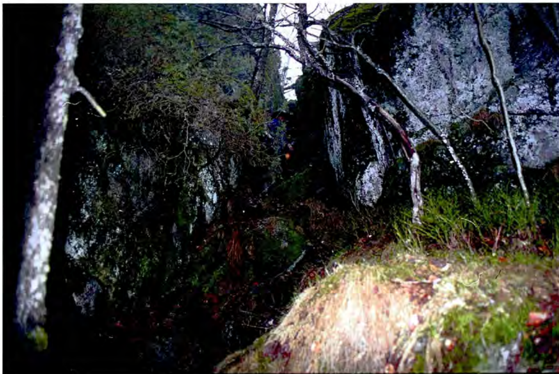
Fig. 4 Åpen sprekk (sone 15) ca. 1 meter bred og med loddrette 3-4m høye vegger. Person, noe skjult bak buskene, er målestokk
