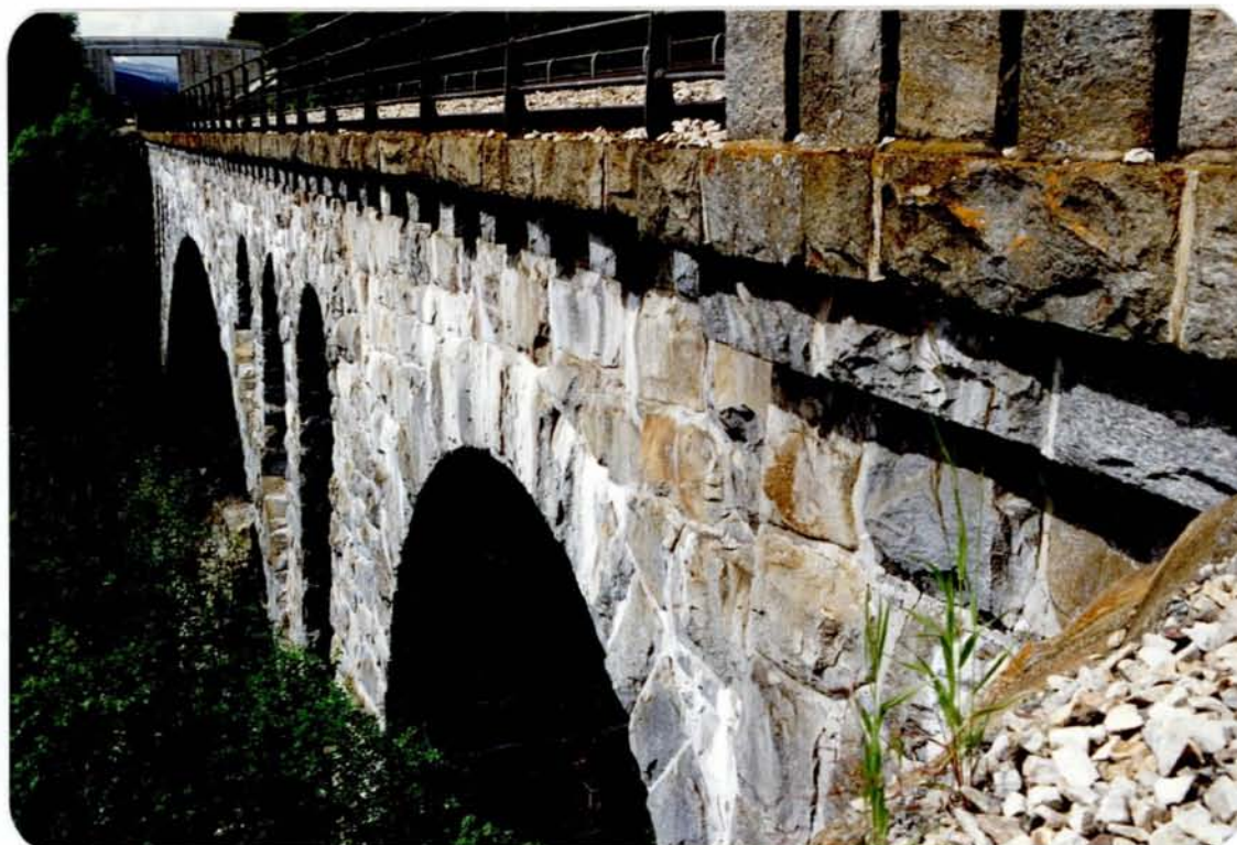
Figur 1 Jernbanebru nordøst for Dombå, bygget av trondhemitt.
