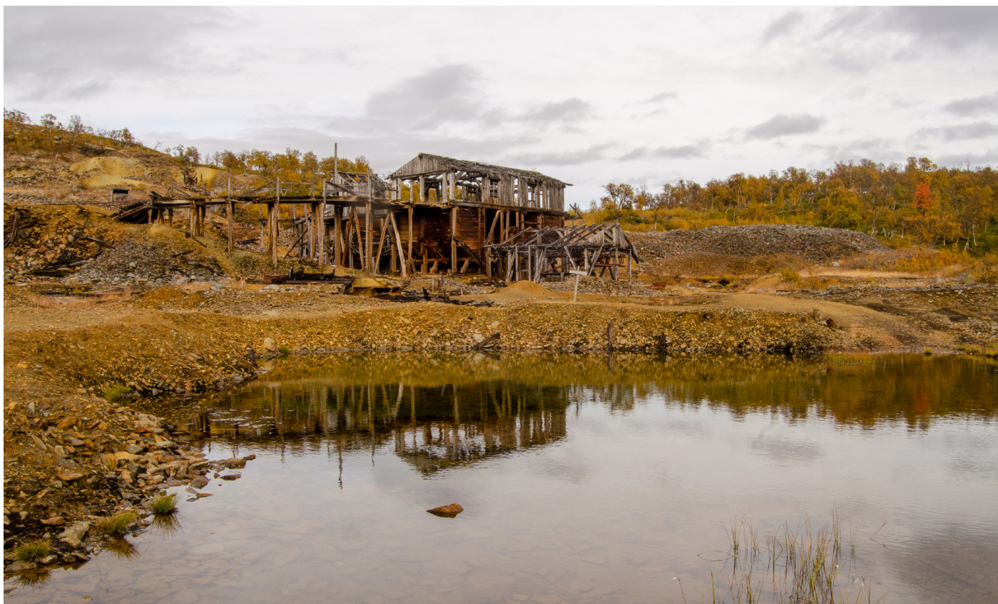
Bildetekst: Den felleferdige taubanestasjonen ved Christianus Sextus gruve ved Røros. Foto: Terje Bjerkgård
