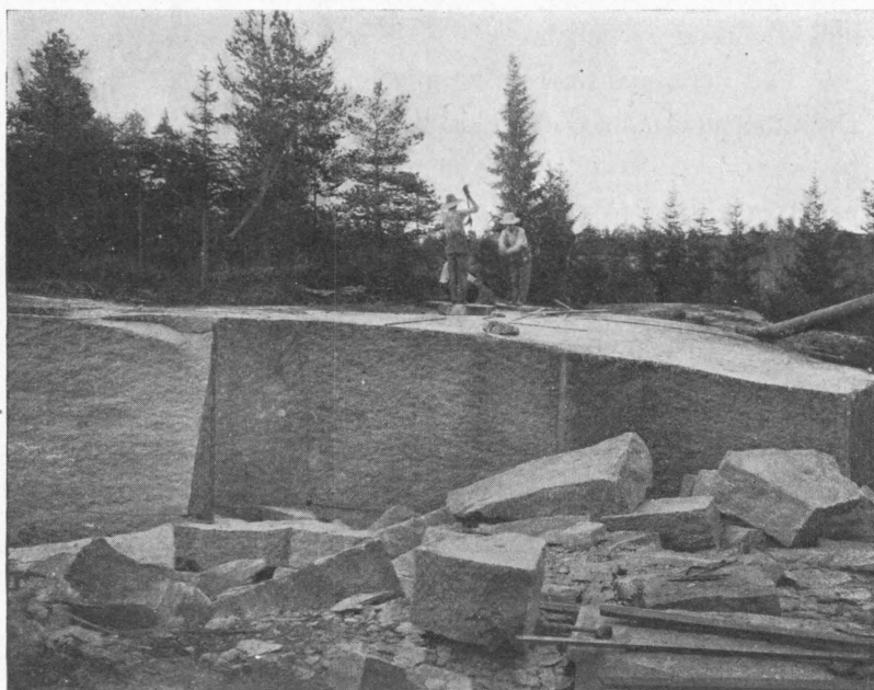
Fra brudd ved Hyggen. Der arbeides i en stor blok paa 1000—1200 tons.
