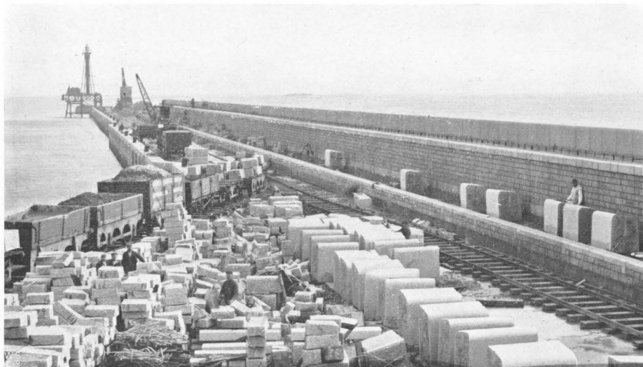
Pier ved marinehavnen i Dover. IDDEFJORDSGRANIT.
