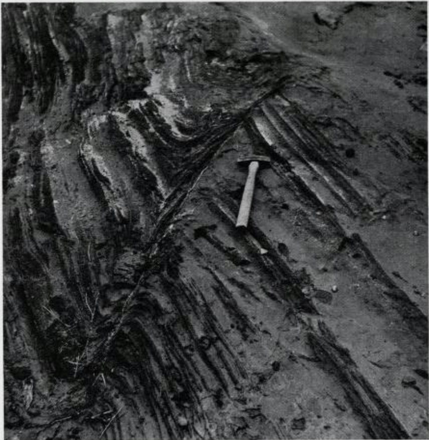
Fig. 15. Foldeforkastninger i marmor. Forkastningsretningen er parallell med et sett skjærsprekker i området. Ved Bleikvasslielva nær utløpet i Røssåga. Fold thrusts in marble. The direction of the thrusts is parallel to one set of the shear joints in the area. At Bleikvasslielva near the outlet into Røssåga.
