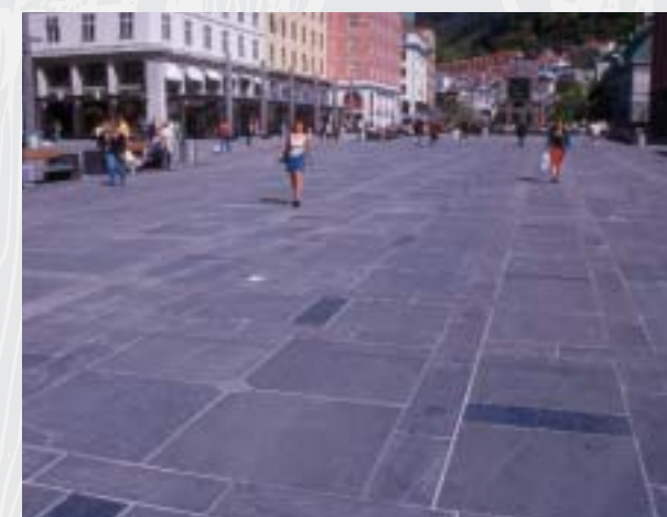
Byrom i skifer – Torgallmenningen i Bergen. Store plater av Altaskifer, striper av Oppdalskifer (grå) og Ottaskifer (svart).
