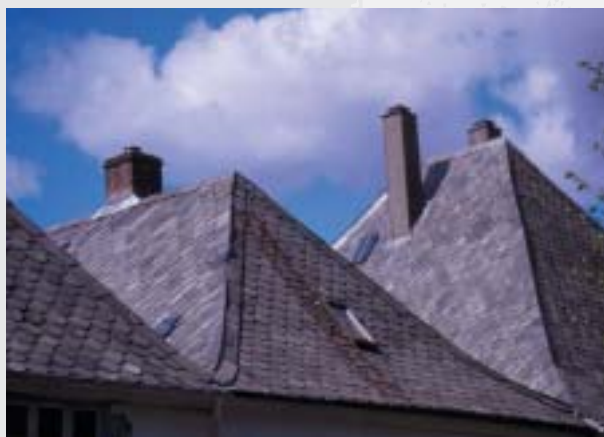
Pent og holdbart. Tak i Vosseskifer.
