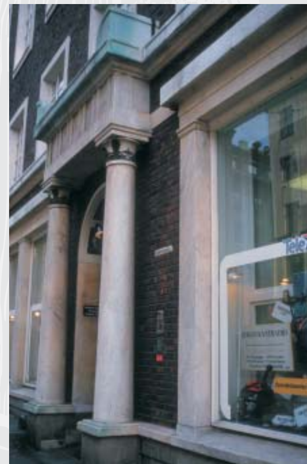
Søyler av hvit marmor fra Tjøtta på Helgelandskysten i telegrafbygningen, Bergen (1930-tallet).
