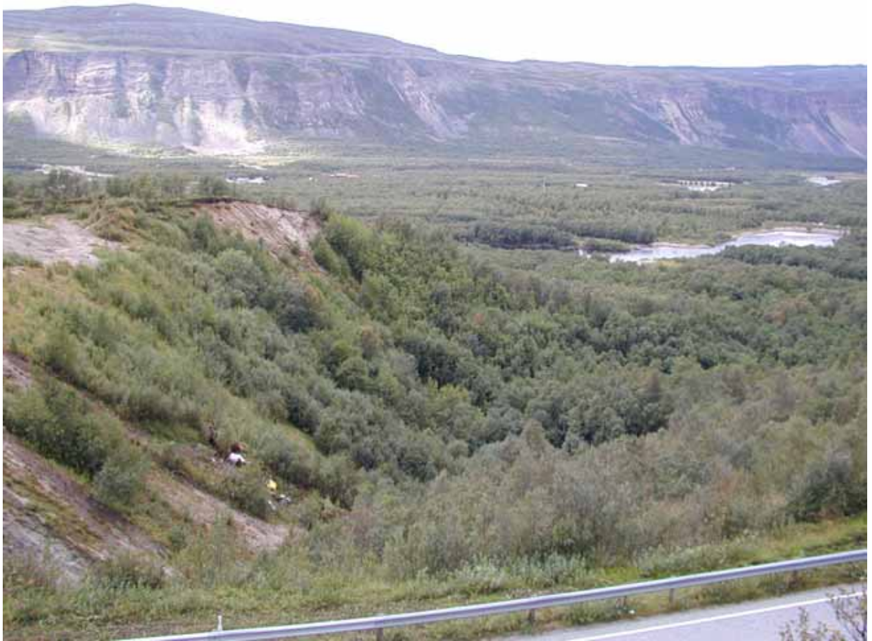
Oversiktsbilde mot vest over det undersøkte området med deponiskråning til venstre i bildet og Lakselva i bakgrunnen. Borsjokka er skjult av vegetasjonen. Standplass og bilderetning for bildet er vist i Kartbilag 2006.037-0 i vedlegg.
