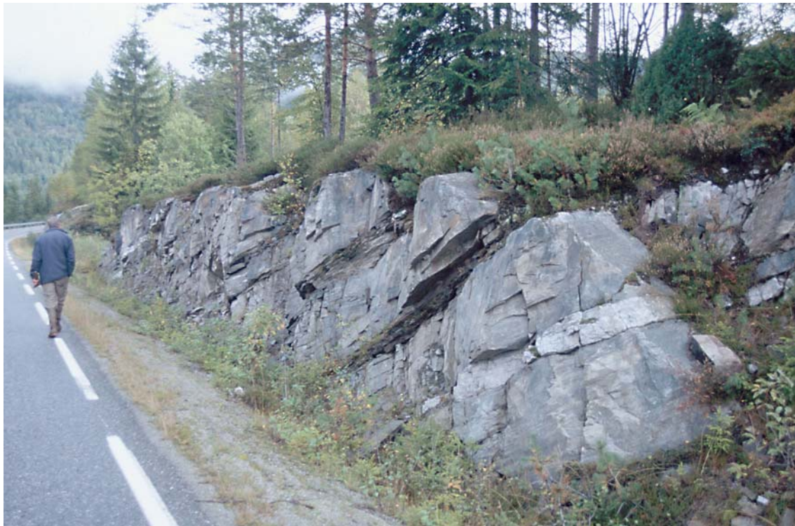
Figur 8 Veiskjæring nedenfor Hegna gård, med granittiske og amfibolittiske bånd i skiferen.
