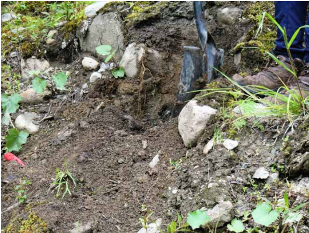
Figur 103: Graving i løsmasser
