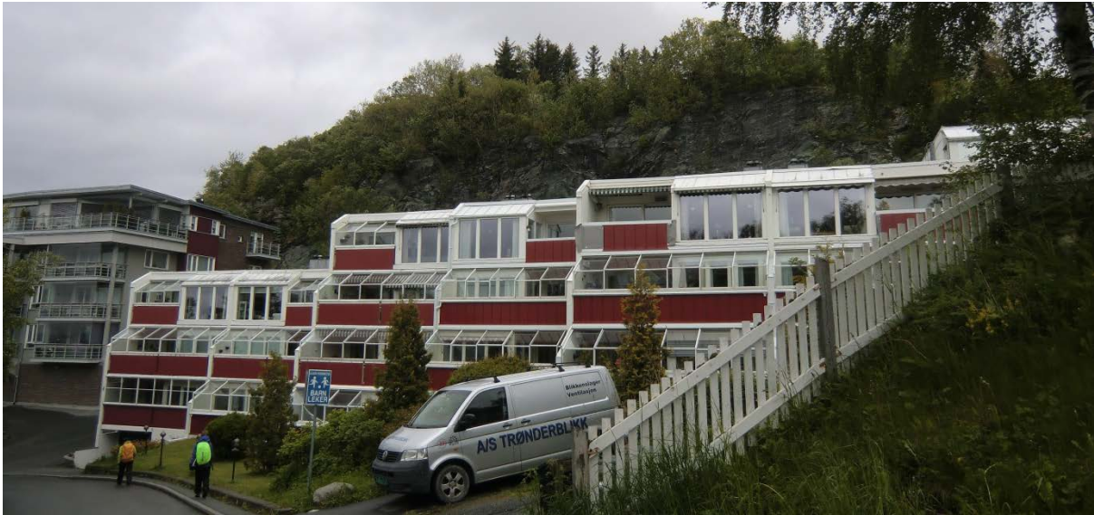
Figur 30: Bakkaunet klebersteinbrudd ligger like bak denne husrekken i Veimester Krohgs gate.
