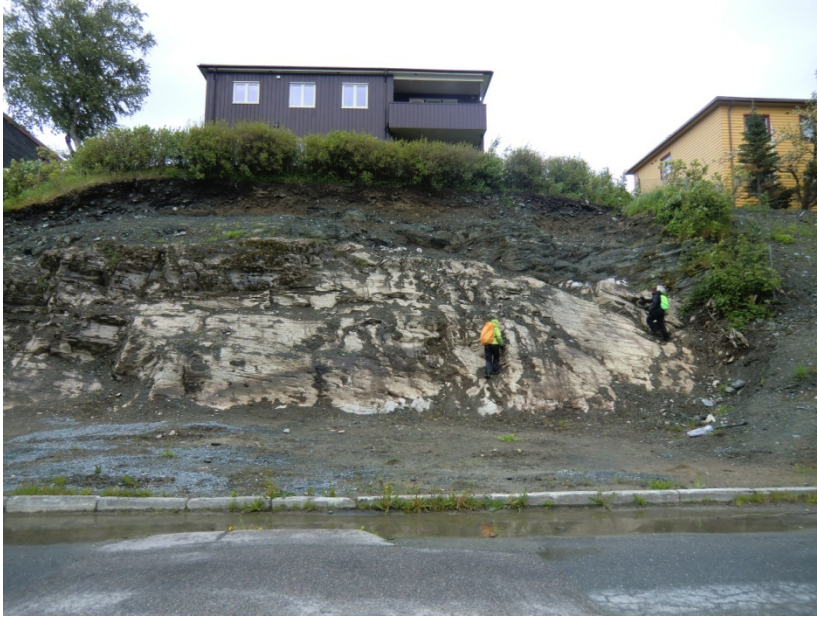
Figur 51: Bergblotningen i Østerlivegen.
