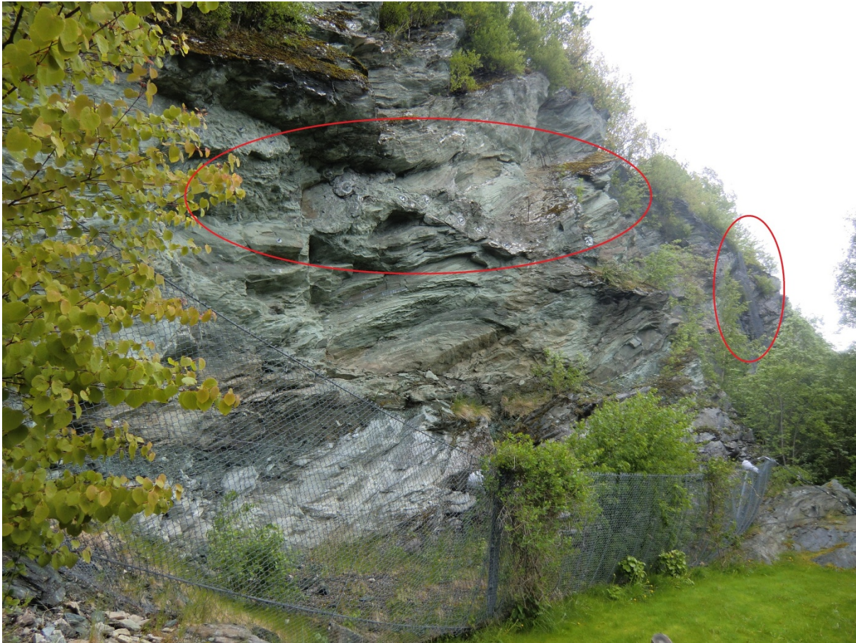
Figur 31: Bergsikring i klebersteinbruddet. Sikringsnettet er markert til høyre i figuren, mens boltene er markert til venstre i figuren. Fanggjerdet ses i nedre del av figuren.
