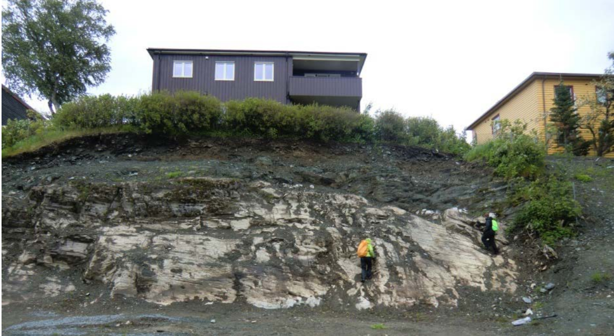
Figur 45: Bergblotningen i Østerlivegen.
