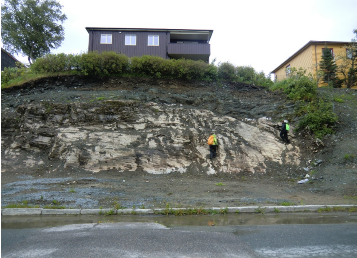
Figur 59: Bergblotningen ved Østerlivegen.
