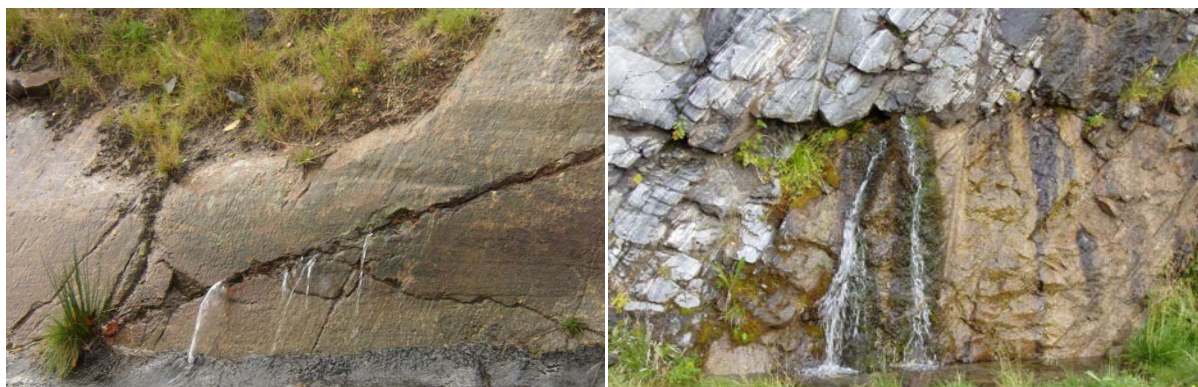
Figur 2 To eksempler av sprekkeakviferer i massive bergarter der grunnvann strømmer langs foretrukne strømningsveier. (foto: B. Frengstad og J. Cramer)
