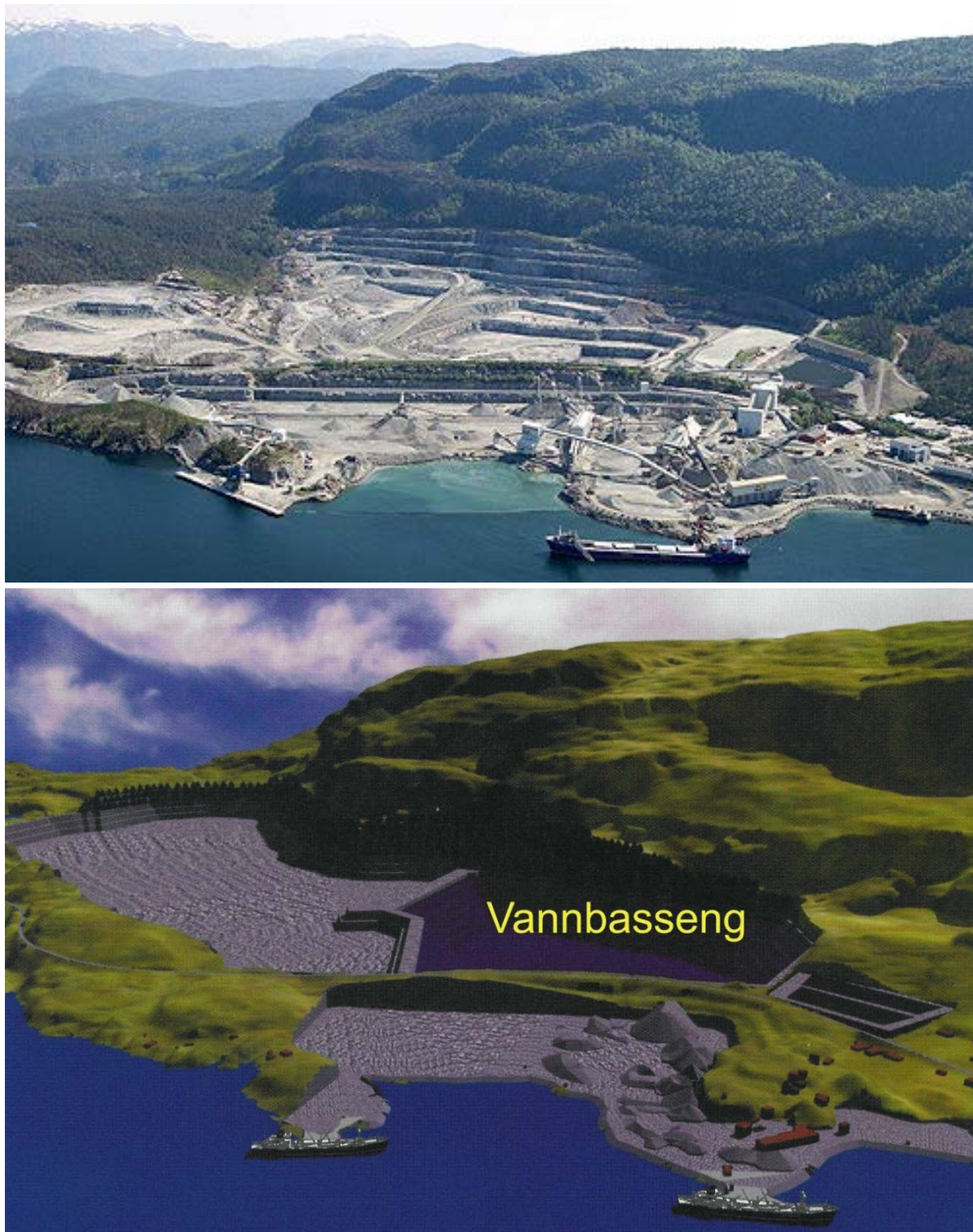
Figur 44 Øverste bildet (fra 2003) viser Berakvam dagbrudd med pukkverk og kaianlegg. Nederste bildet viser planlagt utvidelse av dagbruddet mot NØ og den sørlige delen gjort om til vannbasseng.
