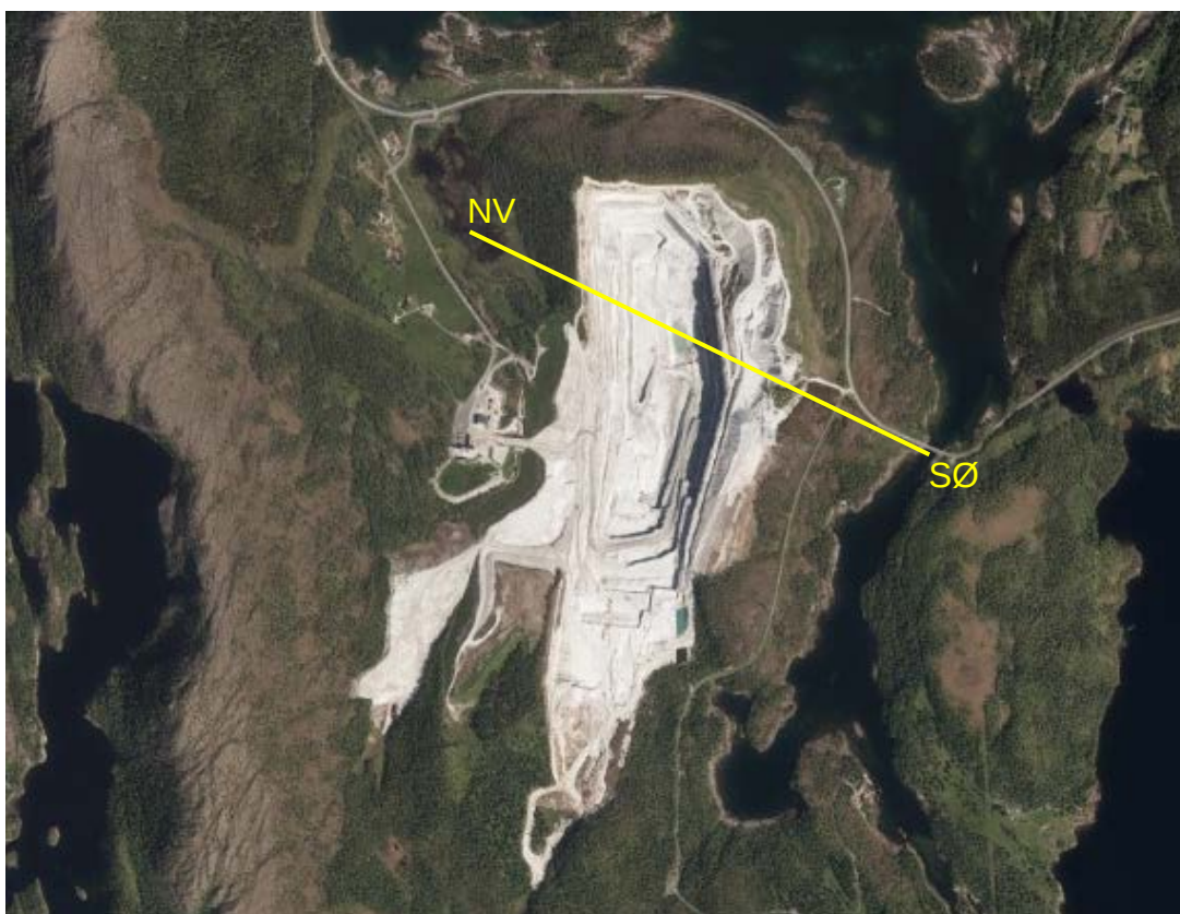
Figur 50 Luftfoto viser Akselberg dagbrudd. NV-SØ linjen er høydeprofilen vist i Figur 54. (kilde: Kartverket).
