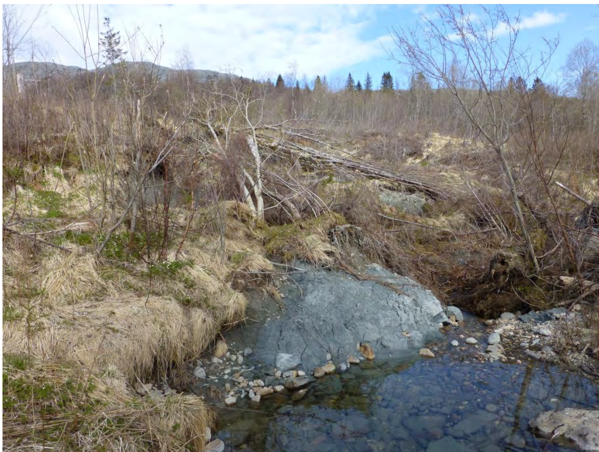
Figur 48. Mindre utglidning i leire i elveyttersving nær munningen av Hellesvikelva. En slik utglidning kan, hvis det er dårlige grunnforhold i skråningen bak, potensielt utløse et større skred. Foto: Louise Hansen.
