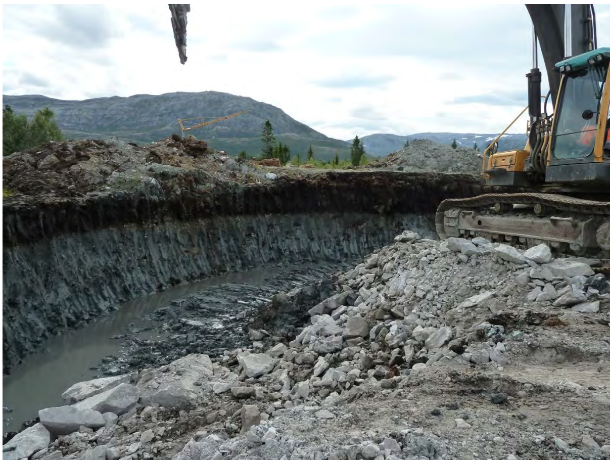
Figur 12. Hav- og fjordavsetninger bestående av leirig silt under myr. Gravearbeidet ble utført i forbindelse med veibygging på tvers av dalen. Foto: Louise Hansen
