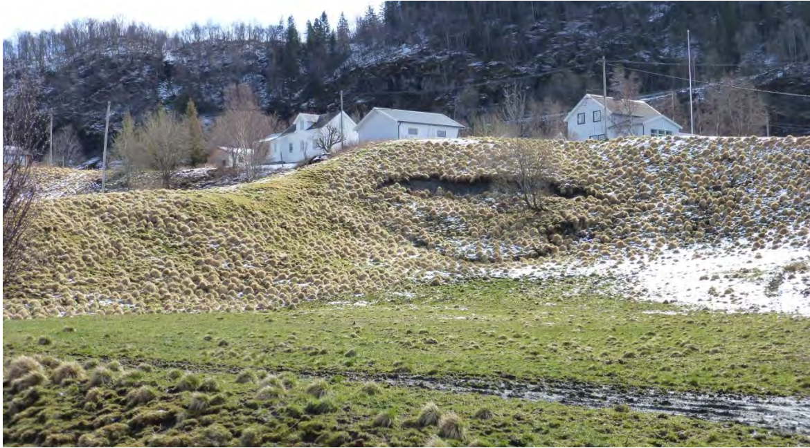
Figur 28. Grunn utglidning i bakkant av grop vist med asterisk i Figur 27. Utglidningen avdekker et lag med skjellholdig grusig sand i toppen av skråningen, mens flaten ved foten domineres av hav- og fjordavsetninger. Utglidningen kan henges sammen med telemelting om våren og er muligens en tilbakevendende prosess. Slike utglidninger kan på sikt påvirke stabiliteten av skråningen, hvilket kan være uheldig dersom det er dårlige grunnforhold. Foto: Louise Hansen.
