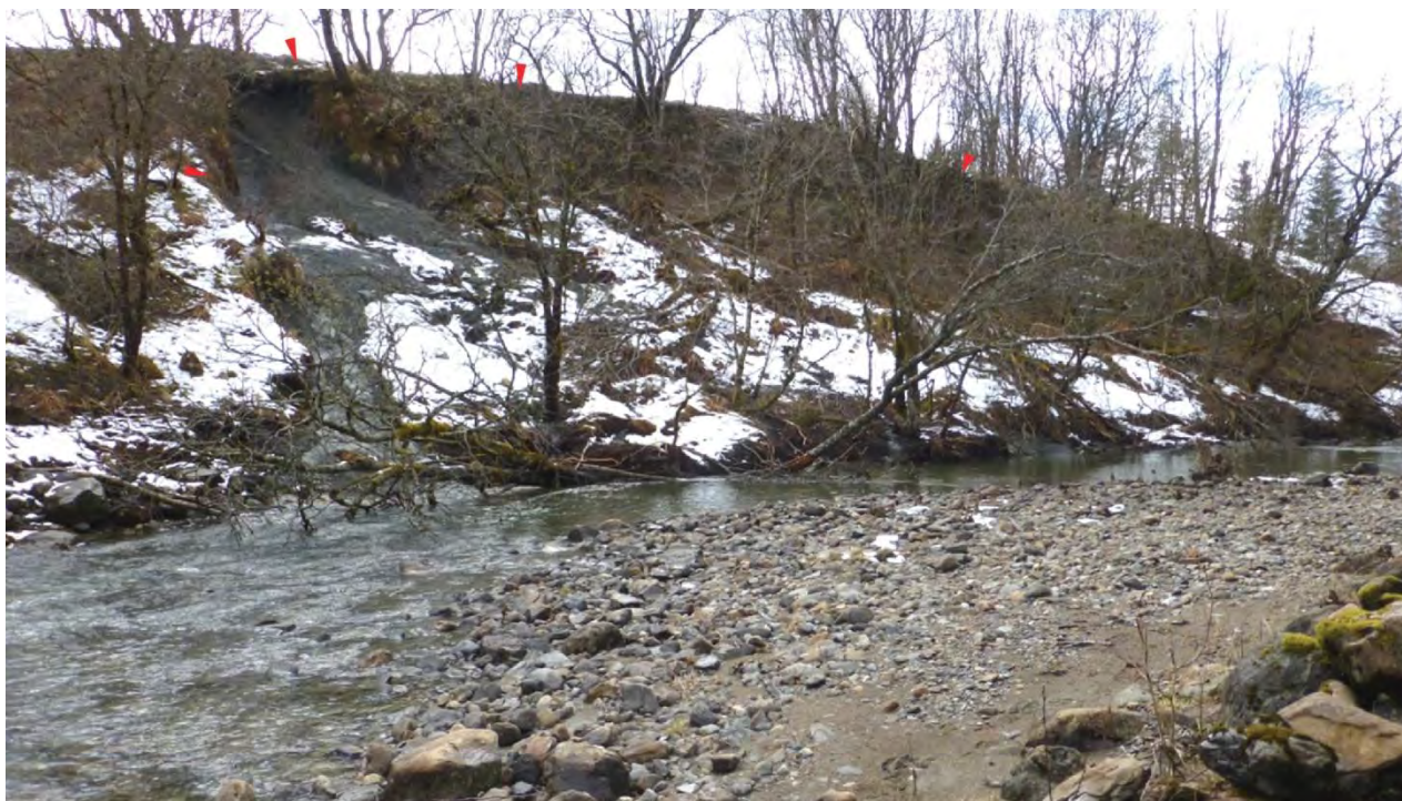
Figur 30. Grunne utglidninger i finkornige hav- og fjordavsetninger i skråning ved elveyttersving langs Nylandselva. Bakkanten av utglidningene er vist med røde piler. Foto: Louise Hansen.
