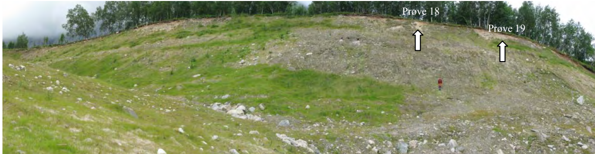
Figur 10. Massetaksskråningen sett mot vest.
