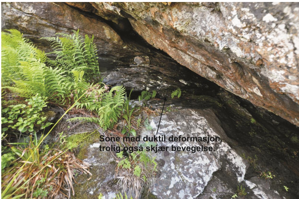
Figur 6. Sone med duktil deformasjon som er observert nær "baksprekken". Denne har orientering 240/56 (høyrehåndsregel). Flere tynne (5-20 cm brede) duktile soner forekommer nær "baksprekken" og kan være en forklaring på det ustabile fjellpartiet. Reaktivering av slike soner på grunn av jordskjelv eller spenningsutløsning etter nedtrykking av isdekke kan gi bevegelse langs slike duktile soner.
