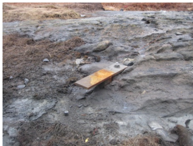
Figur 5. Borehullet på Alstein er sikret med jernplate boltet til fjell.
