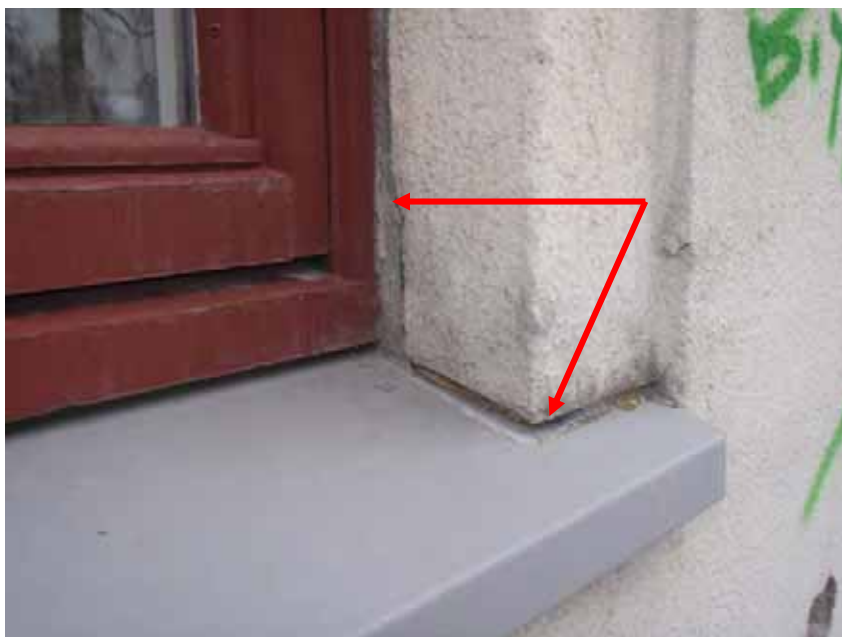
Figur 1. Bildet viser den prøvetatte fugen.
