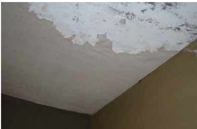
Figur 2. Eksempel på flassende maling.
