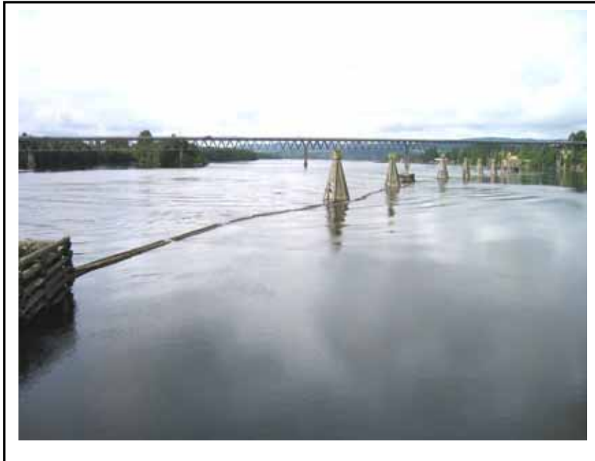
Fig. 9 Lense-system brukt ved tømmerfløting oppstrøms for Fetsund bru. Fetsund bru i bakgrunnen.
