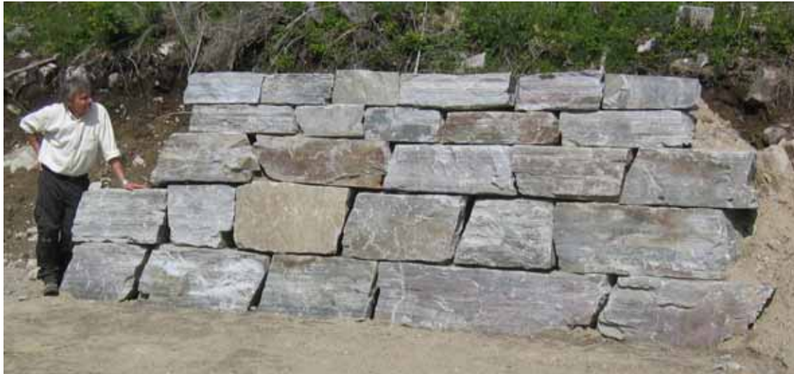
Figur 6: Eksempel på tørrmuring med grovblokk. Ved Grasbottbruddet.
