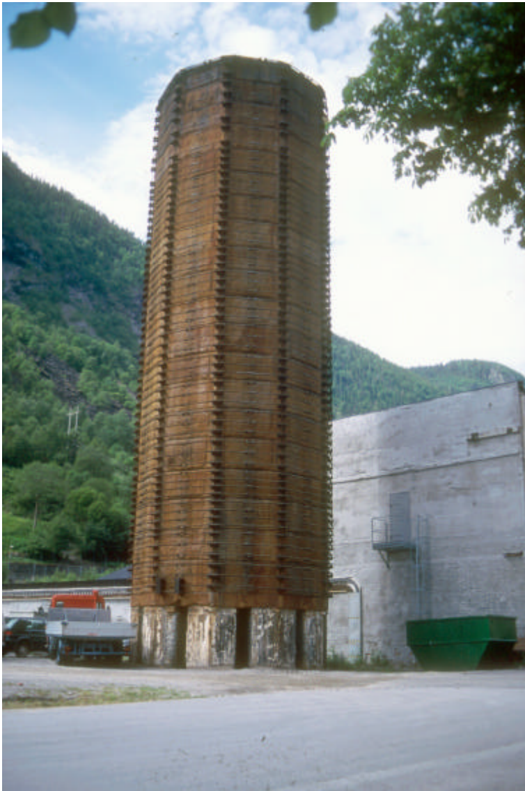
Figur 2. Syretårn av drammensgranitt ved gamle Rjukan fabrikker (eneste gjenværende av 72 tårn)
