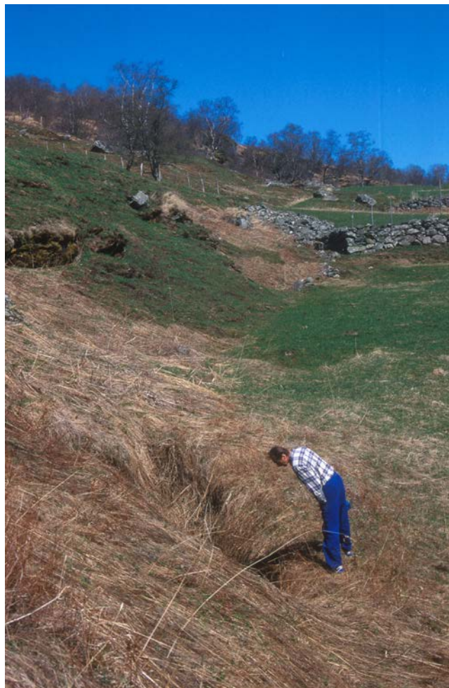
Fig. 22B. Utglidningen eller sprekken nedenfor Vidme. Foto mot nord. Legg merke til innsynkningsgrop.
