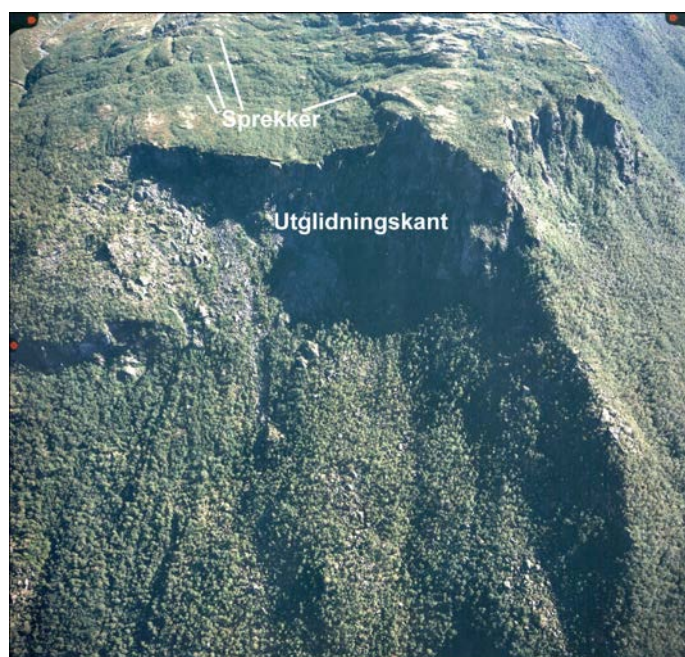
Fig. 10. Skråbilde mot utglidningskanten sør for Stampa. Legg merke til de store sprekkeområdene oppe på plataet på Furekamben.
