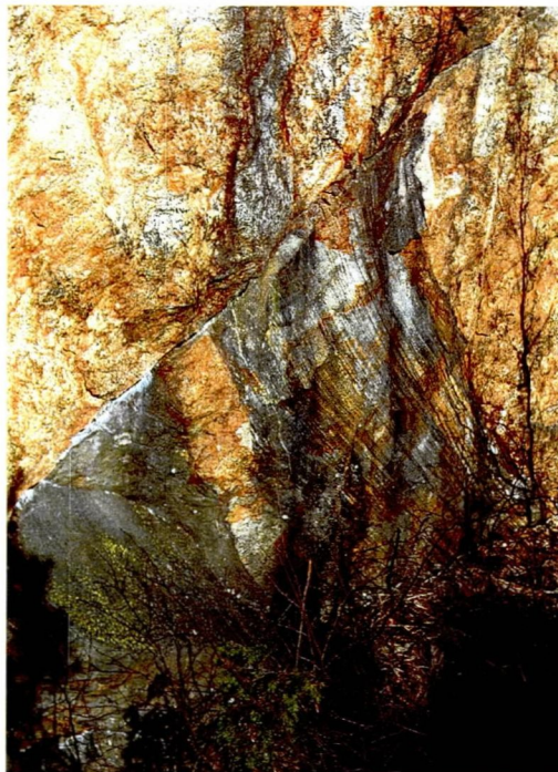
Fig. 4. Fotografi av forkastning som gjennomsetter pegmatitt-kroppen på Rustfjellet (30). Nordveggen av skjæring mellom bruddene. Lengste kant av bilde er 2m.
