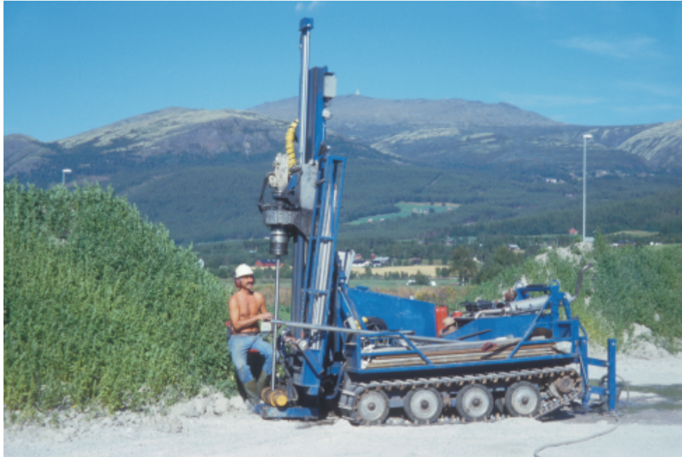
Figur 5. Boring ved Taverna hotell og kafeteria i Alvdal.
