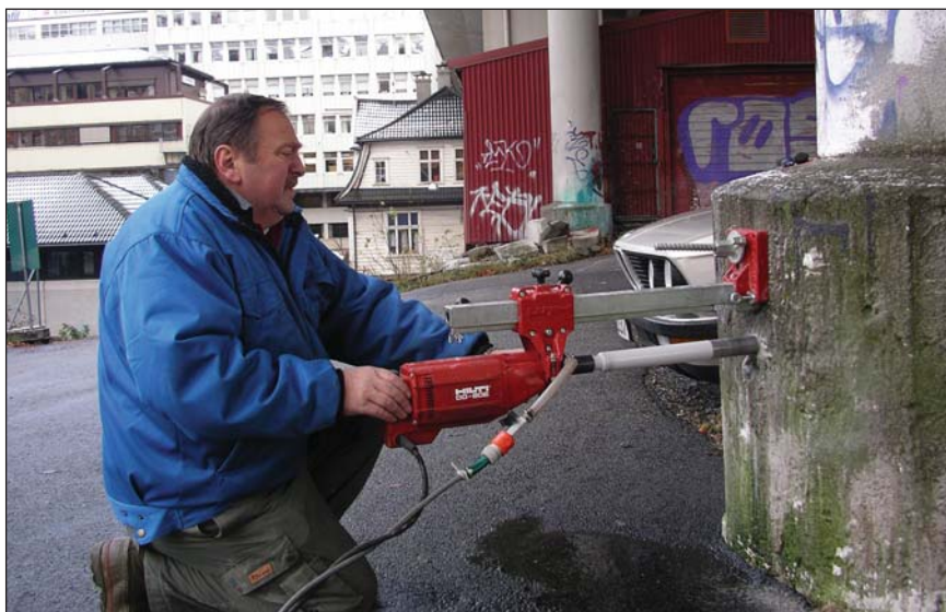
Prøvetaking med kjerneboring av betongkonstruksjoner.
