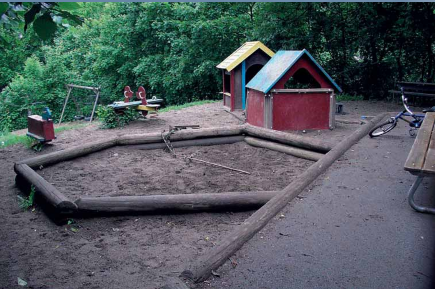
FIGUR 7 Bruk av CCA-impregnert trevirke rundt sandkassen i en barnehage.
