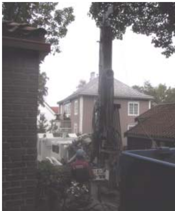
Figur 8. Boring av energibrønn.
