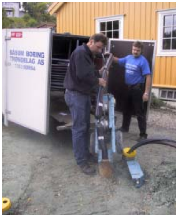
Figur 9. Nedsetting av kollektorslange i energibrønn.
