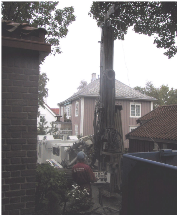
Figur 8. Boring av energibrønn.
