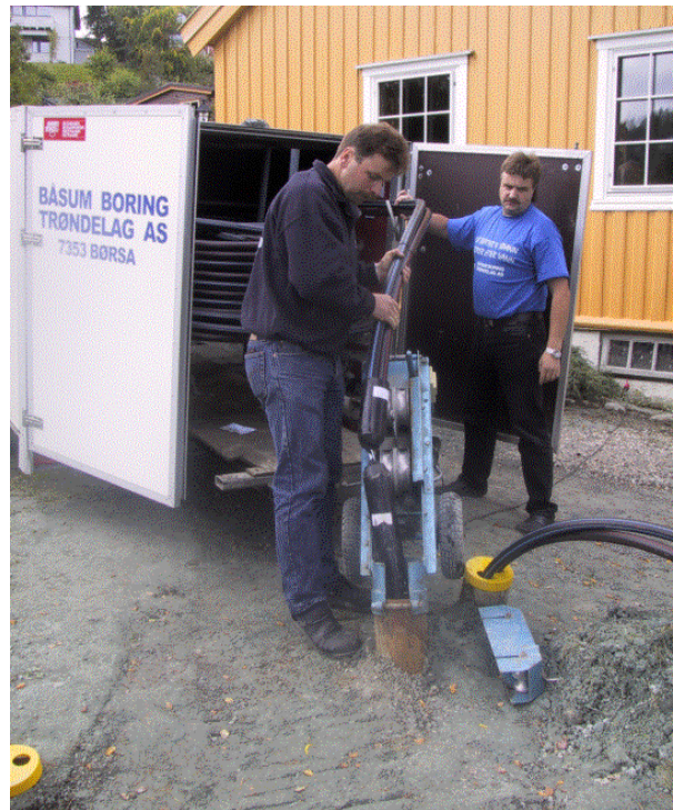
Figur 9. Nedsetting av kollektorslange i energibrønn.
